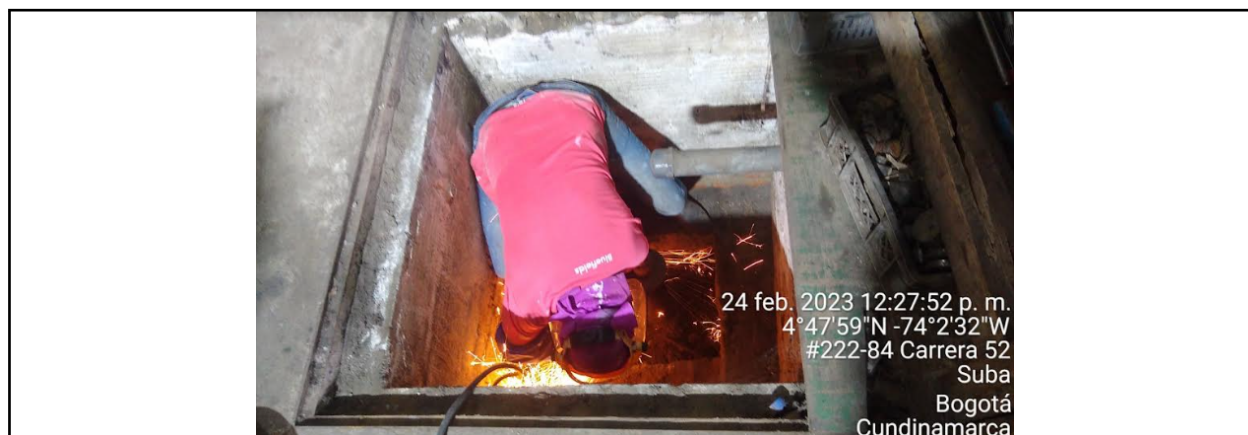
Fotografía No. 1 Corte de tubería galvanizada del pozo
