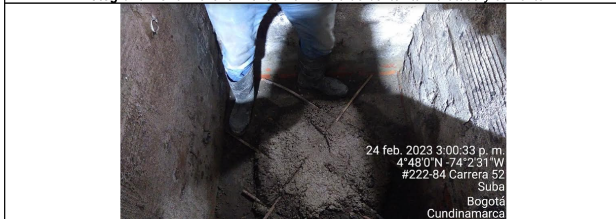
Fotografía No. 7 Llenado con cemento y bentonita hidratada y refuerzo con varilla de hierro
