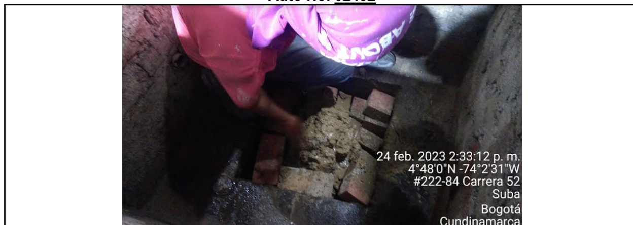
Fotografía No. 6 Relleno final con la mezcla de bentonita hidratada y cemento
